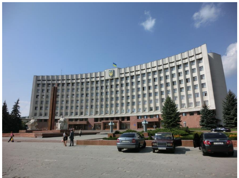
Verwaltungsgebäude aus der sowjetischen Zeit.
